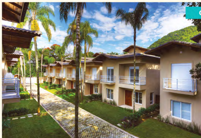
FOTO DA ALAMEDA DO EMPREENDIMENTO
